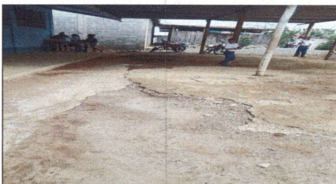
Foto 4: Reparación de planchas de concreto de patio
